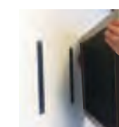
受プレートに吸音パネルのマグネットを合わせれば完成です。
