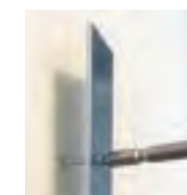
受プレートを付属の皿ネジとアンカーで壁に取り付けます。
